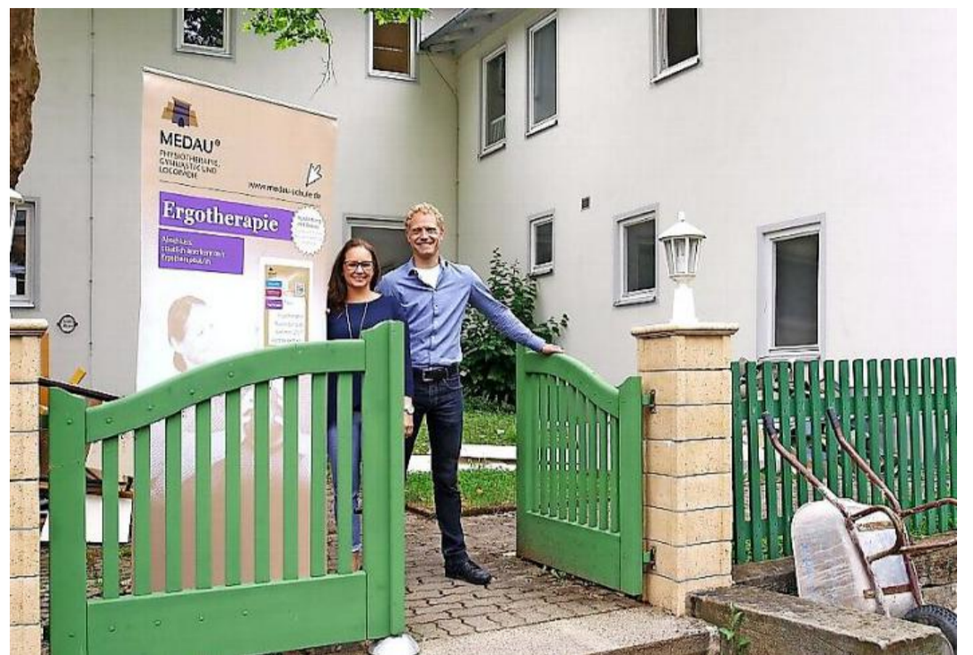
Noch beherrschen Bauarbeiten das Geschehen in den künftigen Werkstätten für die ergotherapeutische Ausbildung in der Medau-Schule in Schloss Hohenfels. Schulleiterin Nicole Schuhmann und Peer Medau sehen dem Start mit Spannung entgegen. Die erste Klasse beginnt Mitte September. Foto: Christoph Winter
